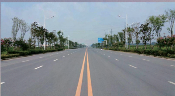
蒙城县城南新区西片区及开发区南区道排工程（黄山杯）
