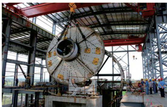
庐江矿业设备安装
