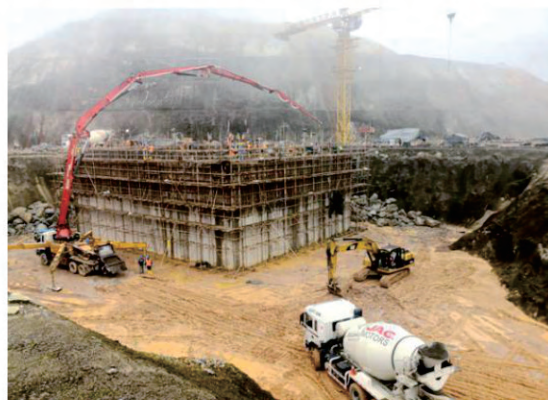
米拉多铜矿废石破碎站
