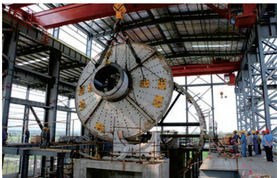
庐江矿业设备安装
